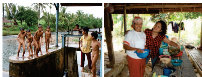
図 2 インドネシア西スマトラ州パラックブルック堰
