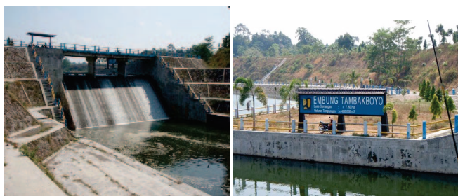
図 1 インドネシア中部ジャワ州エンバングタンバックボヨ堰
