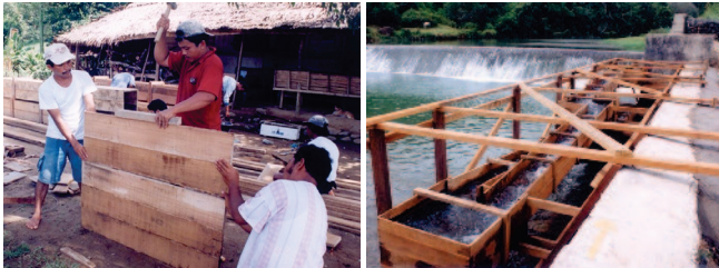
図 4 パラックブルック堰での仮設魚道の設置
