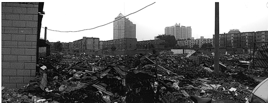
写真1 六道口旧住宅街取壊し現場 2006年8月26日撮影
